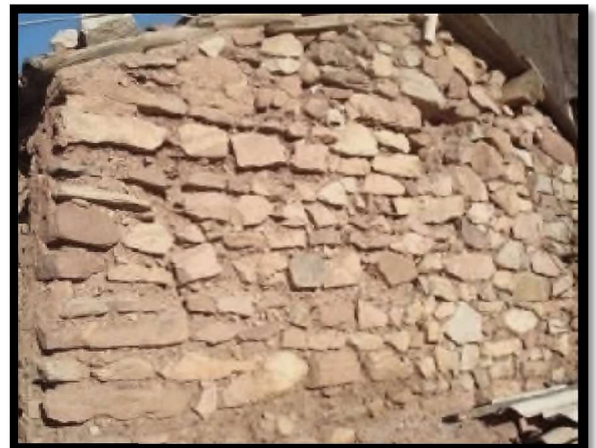
Figure 42 : les formes irrégulières des pierres village Derna, Ath Yenni, Tizi-Ouzou. Source : le mémoire de master SIARI. S et ZIBOUCHE. T 2013. P 55.
