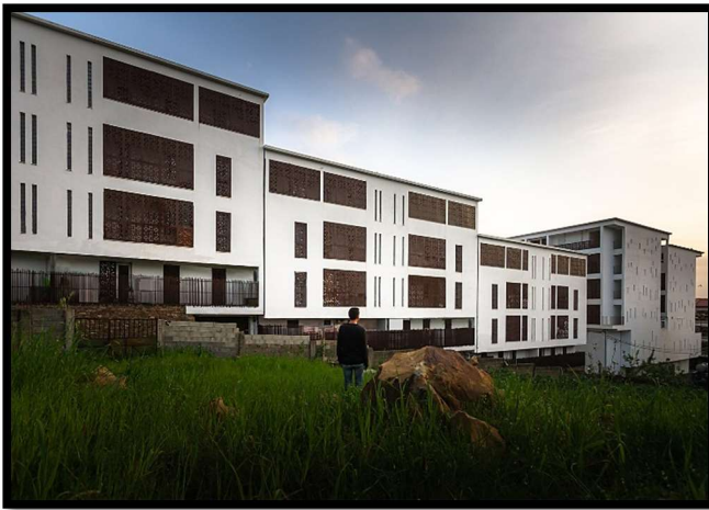
Figure 51 : Les façades de la résidence tirsanine. Source : https://www.ateliermessaoudi.com
