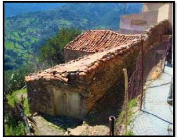
Figure 44 : Toiture a un seul versant, village Djebba, Bejaia.
