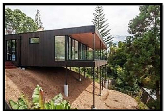
Figure 12: Image d'une Maison sur pilotis.
