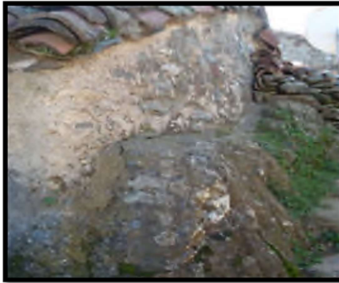
Figure 37 : les fondations d'une Maison au village Beni Douala.
