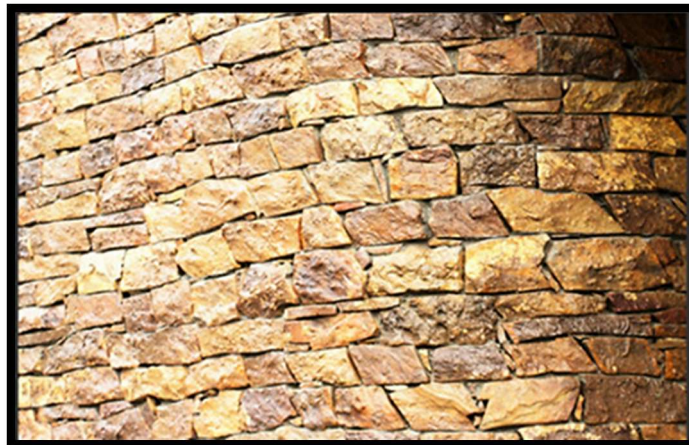
Figure 55 : Socle de pierre de la résidence tirsanine. Source : https://www.ateliermessaoudi.com
