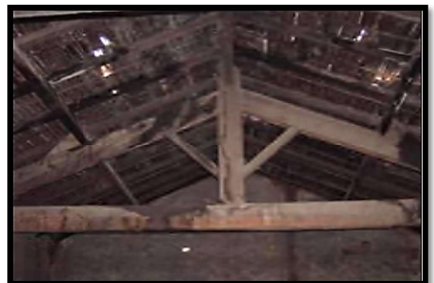
Figure 43 : Ossature en bois d'une maison kabyle à Maatkas Tizi-Ouzou. Source : www.villagekabyle.com
