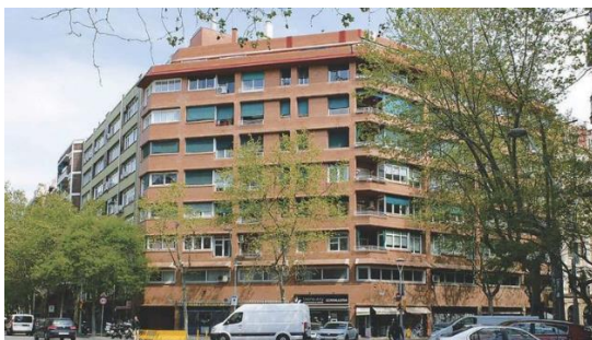
Figure 7: L'immeuble de la carrer de Casp
