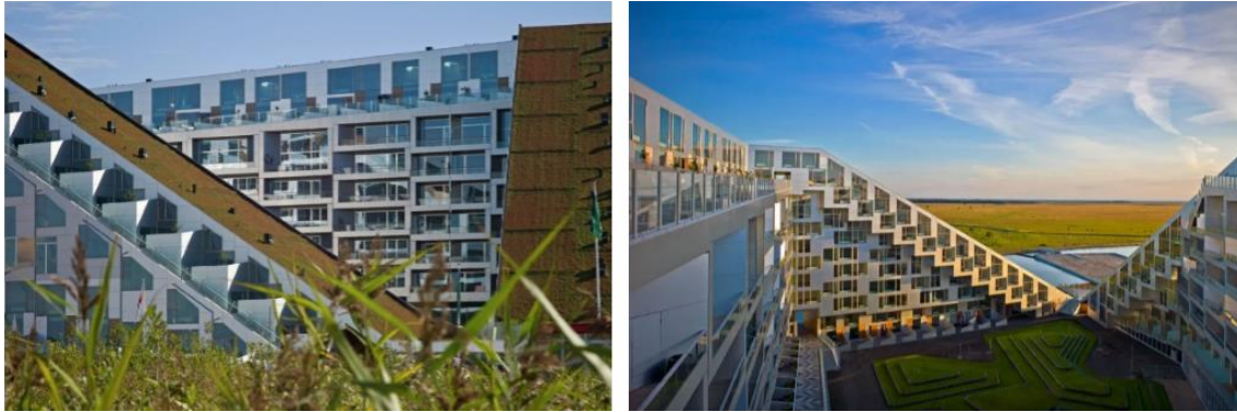
Figure 56: Vue sur 8 House
