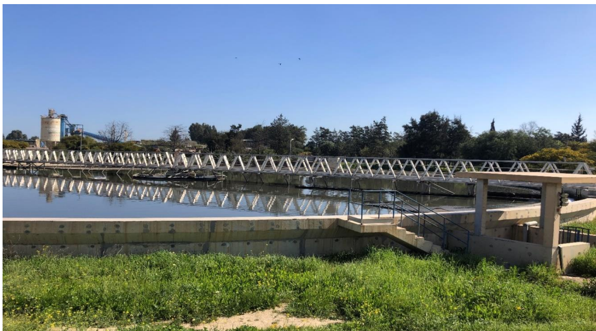
Figure III. 19. Bassin de décantation primaire
