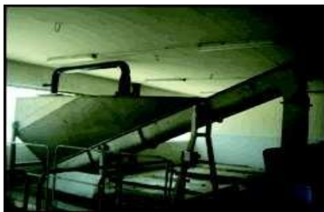
Figure III. 18. Classificateur à sables de la STEP Baraki
