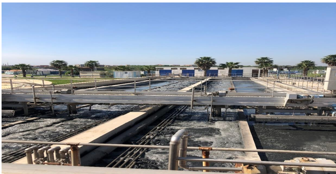
Figure III. 17. Dessableur- déshuileur de la STEP Baraki,
