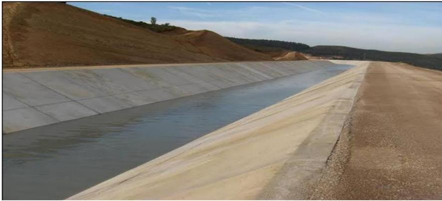
Figure V.1: Exemple d'un canal en béton armé.
