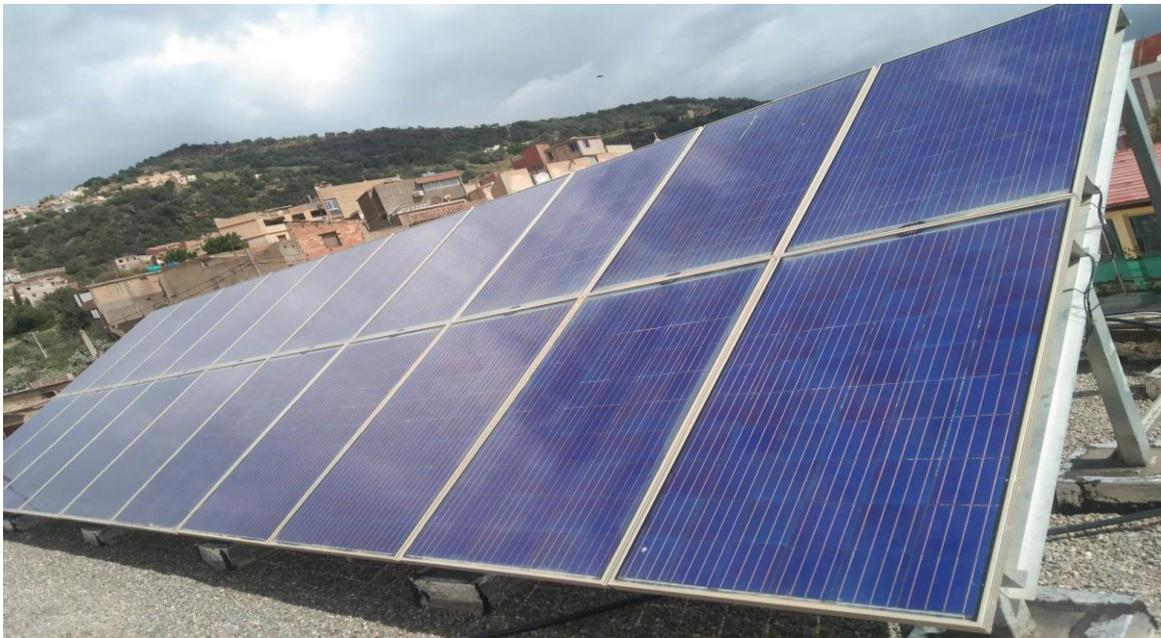
**Figure I. 8:** Installation solaire photovoltaïque raccordée au réseau Sonelgaz + pompage
