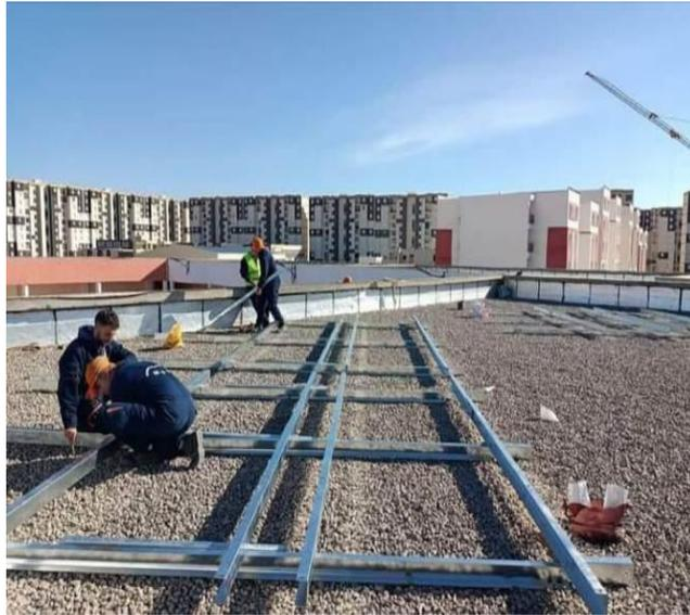
**Figure IV . 3:** Structure porteuse des panneaux
