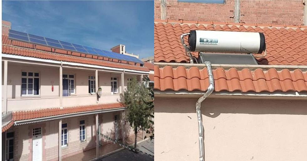
**Figure I. 7:** Installation d'un système solaire d'une puissance 10KW et la pose d'un chauffe-eau solaire d'une capacité de 200L
