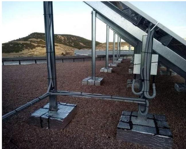
**Figure IV . 4:** Raccordement des panneaux
