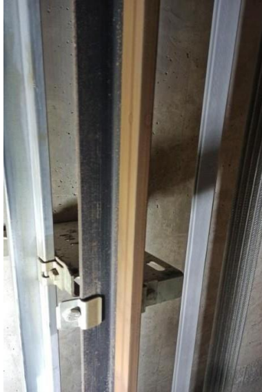
Figure I.13 : Guide de cabine
