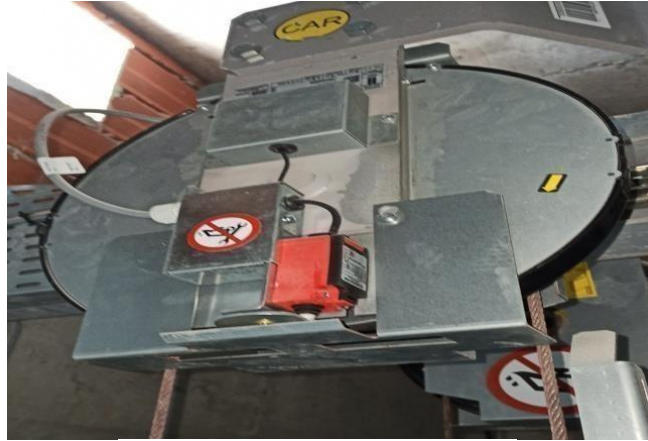
Figure I.10 : Limiteur de vitesse
