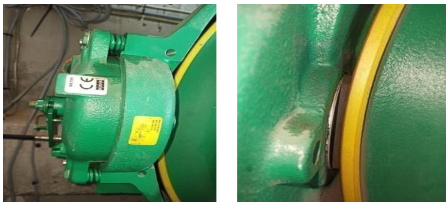
Figure I.15 : Freins moteur
