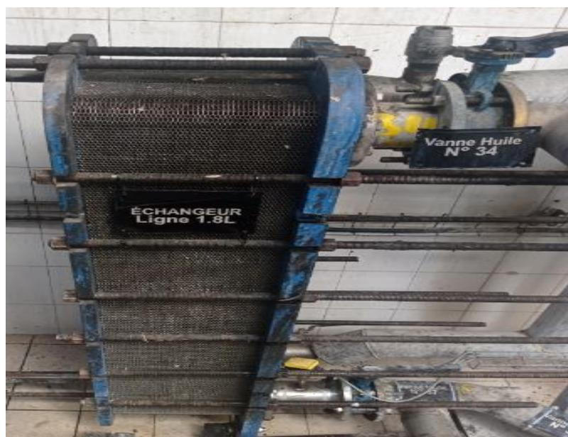
Figure II.15 : Echangeur à plaque
