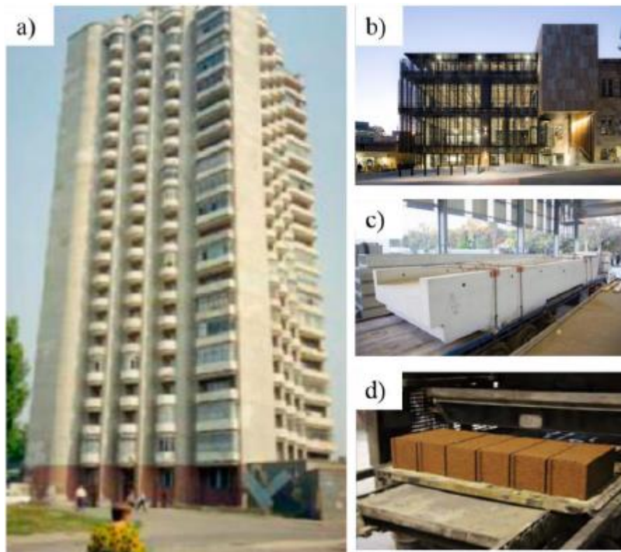
Figure I-2 : Quelques applications de matériaux géopolymères dans le Génie Civil a) Bâtiment en géopolymère [63], b) Université de Queensland en béton de géopolymère, c) Structures préfabriquées en béton géopolymère [64] et d) Briques en géopolymère [65]
