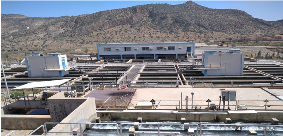
Figure II-3: Vue de la station de traitement d'eau potable Tichy-Haf (photo personnelle, 2023).
