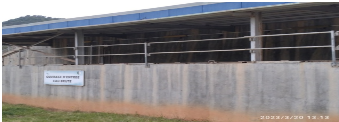
Figure II-4: L'ouvrage d'entrée : point de prélèvement de l'eau brute (photo personnelle, 2023).
