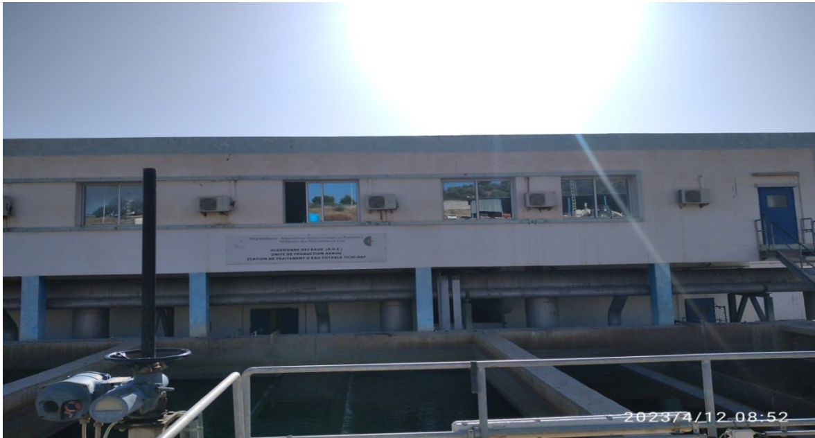
Figure II-11: Le bâtiment de contrôle des procédures de traitements (photo personnelle, 2023).
