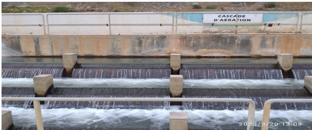
Figure II-5: Cascades d'aération, point de prélèvement d'eau (photo personnelle, 2023).
