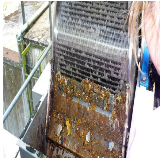
Figure I.5: Dégrilleur secondaire fin.
