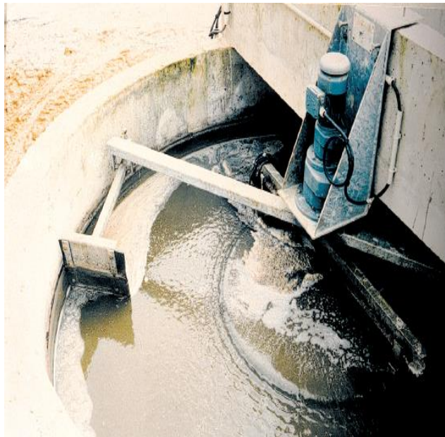
Figure I.7: Déshuileur-Dégraisseur.
