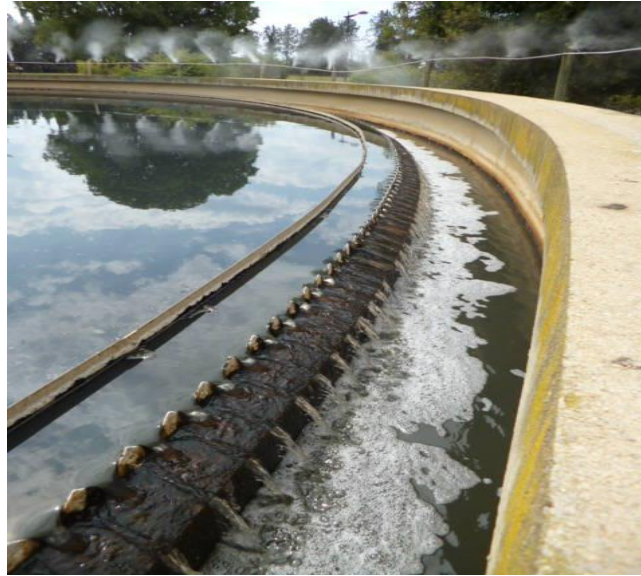
Figure I.8: Décanteur primaire.
