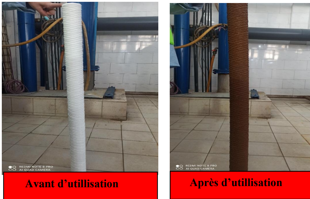
Figure II.9 : photographie d'un filtre à cartouche bobiné au niveau de Cevital.
