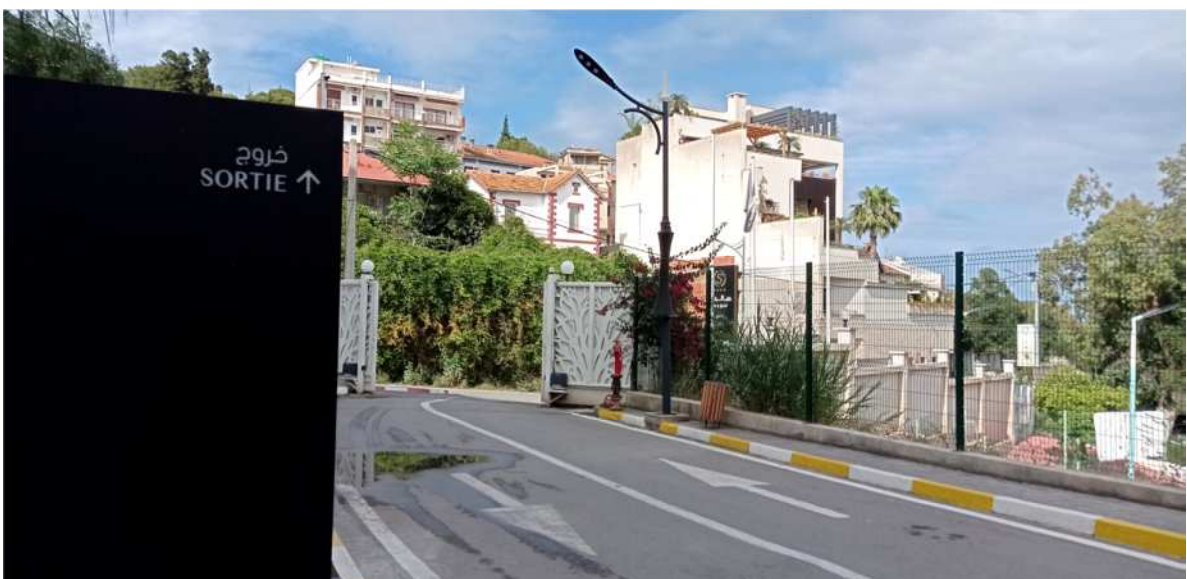
Figure III-2 : Photo de l'emplacement du poste de sécurité se trouve à l'entrée principale de l'hôtel.
