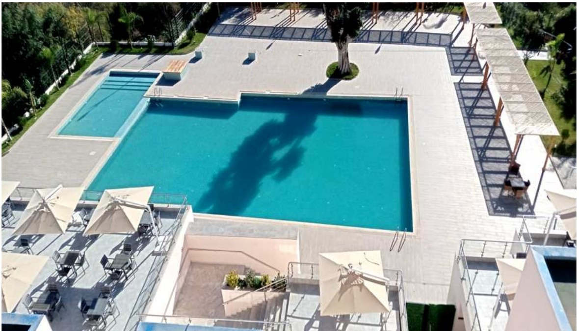
Figure III-9 : Photo de la piscine de l'hôtel
