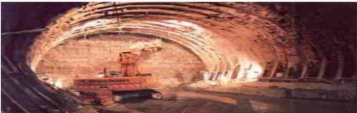
Figure I.3 Creusement a pleine section [C]
