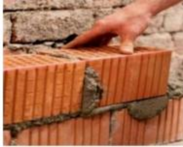
Figure I.5 : Le hourdage de maçonnerie.
