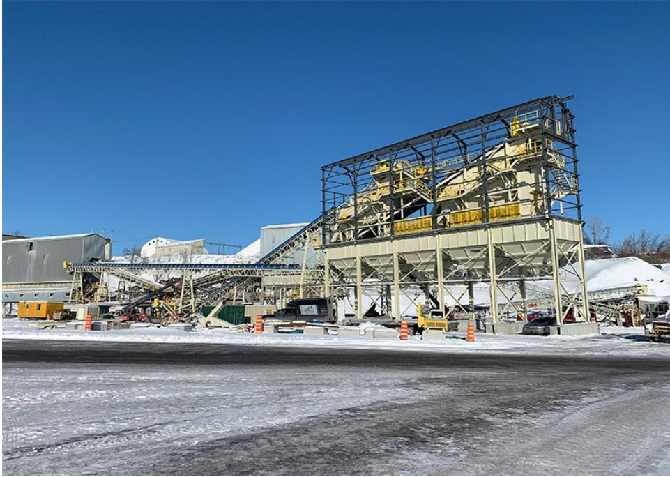
Figure I. 7. Concasseur et la ligne de production de Gypse & du plâtre
