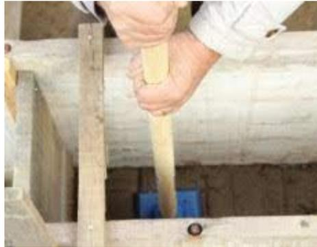
**Figure 1.3 :** Compactage des couches de terre crue à l'aide d'un pisoir [3]
