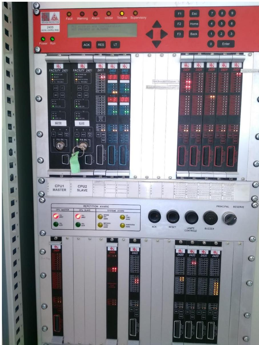
Figure II.4: Centrale de détection/extinction d'incendie existante à SBM
