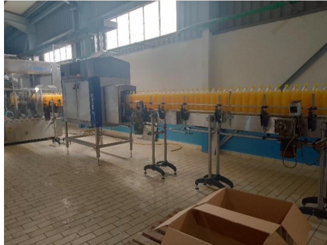
Figure 1.8 : Tunnel de soufflage
