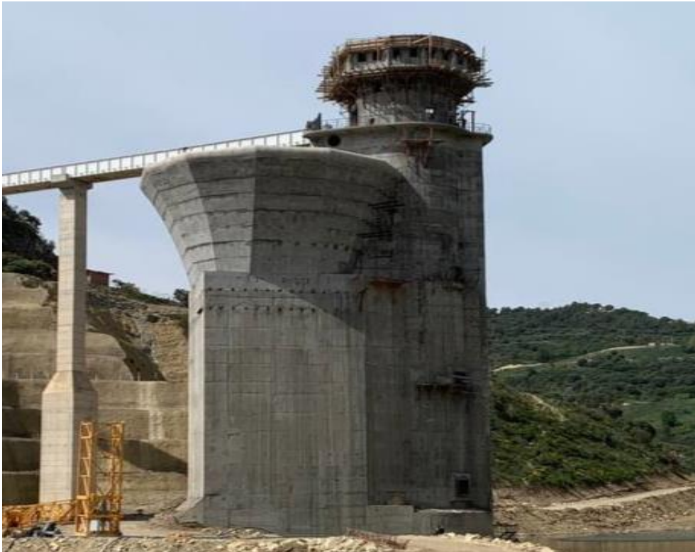
Figure II.17 : photo de l'évacuateur de crue (prise durant le stage)
