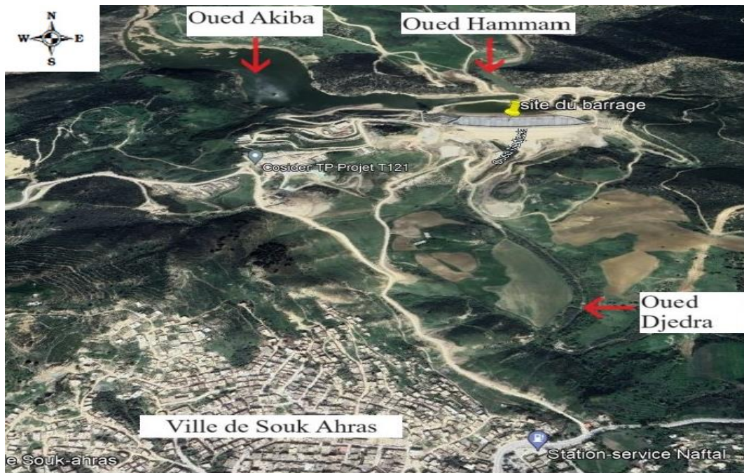
Figure I.1 : localisation du barrage (image extraite de google earth)
