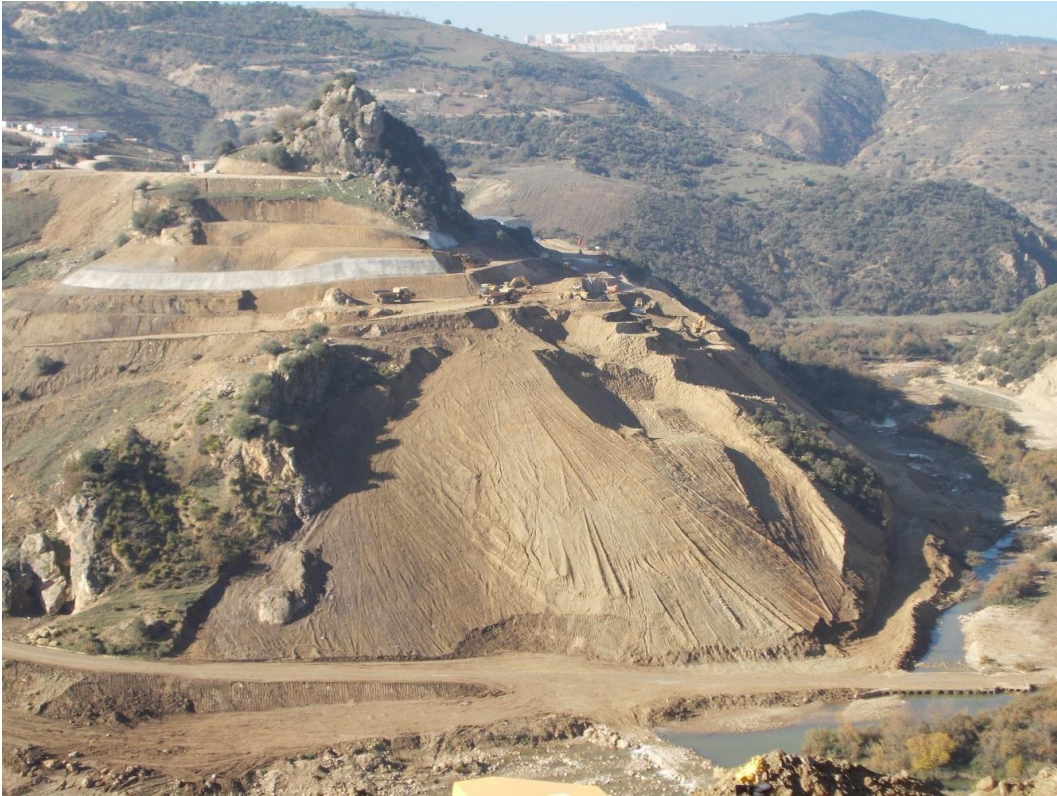
Figure II.9 : le site du barrage oued Djedra (ANBT)
