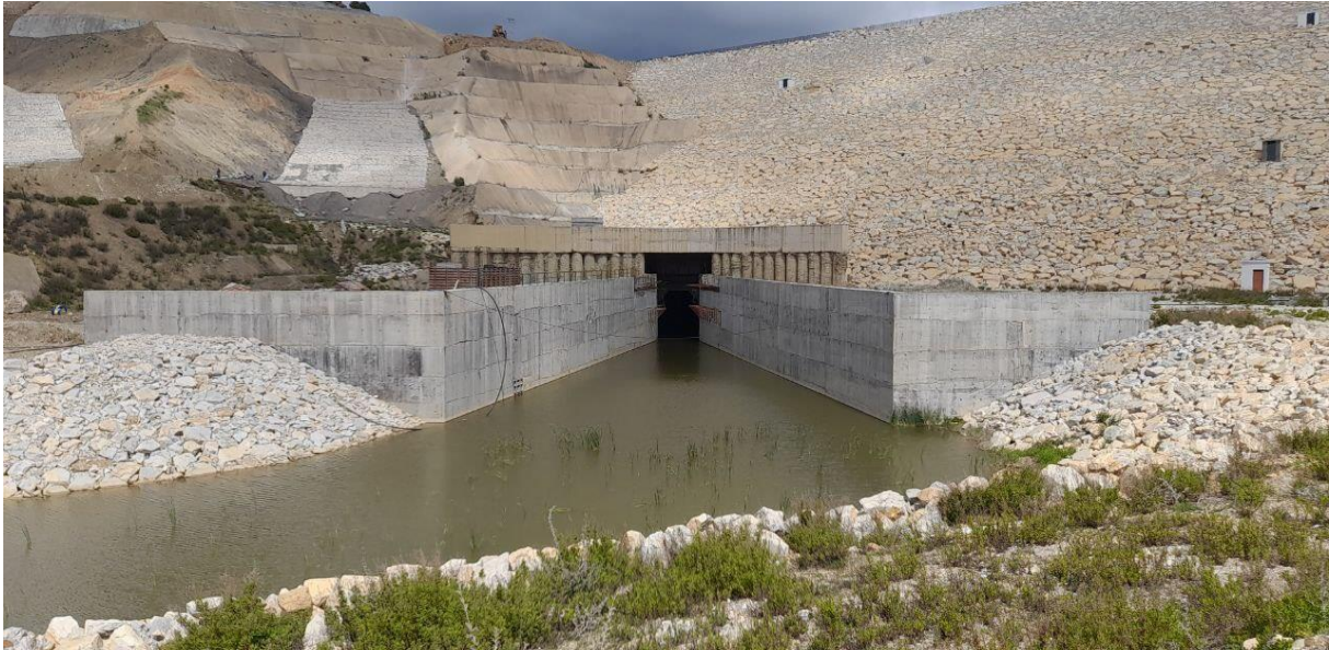
Figure II.20 : photo réelle de bassin d'amortissement (prise durant stage )
