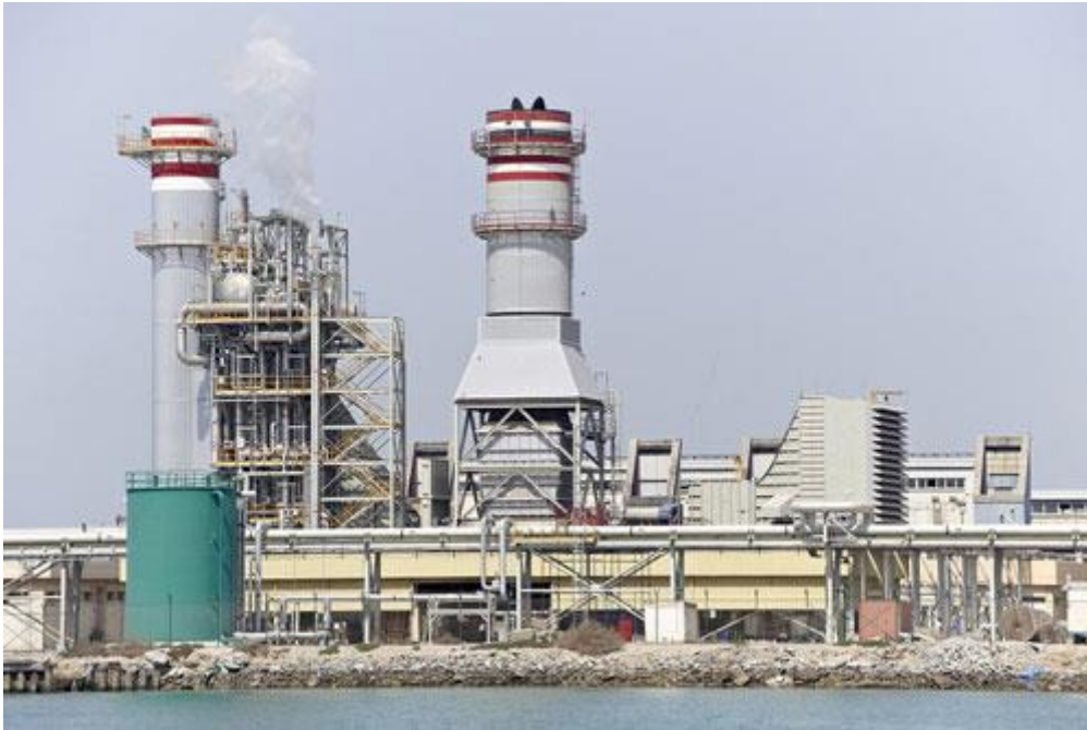
Figure I.8 : Station de Dessalement de Tighremt wilaya de BEJAIA
