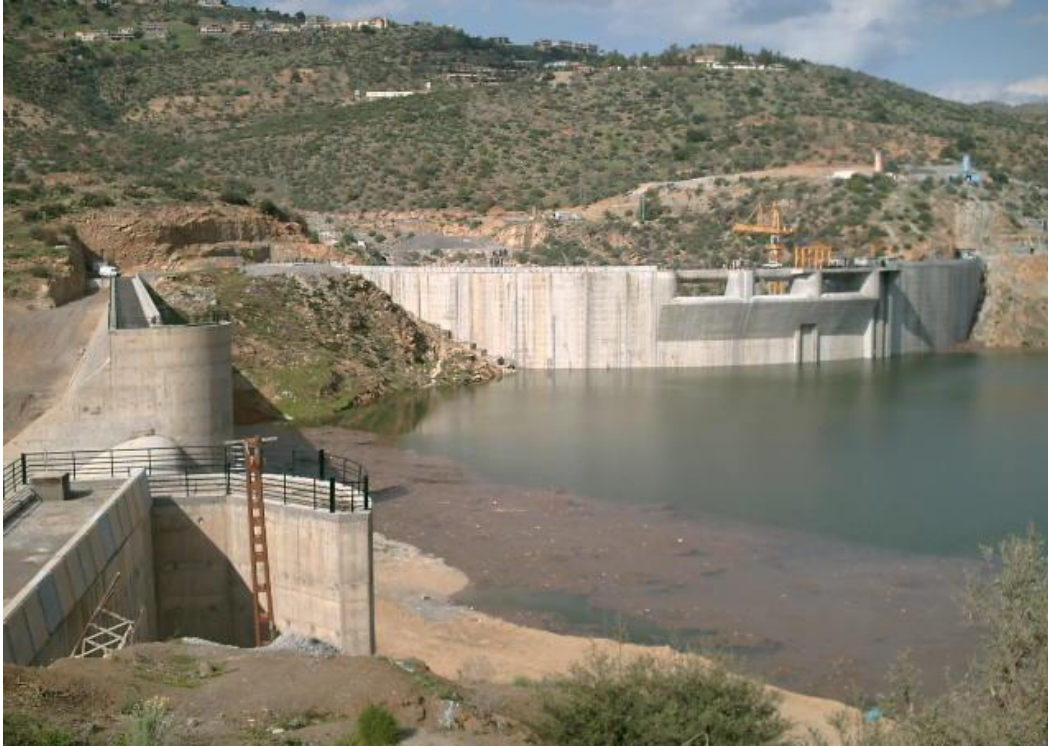
Figure I.5 : Vue de la digue et des deux évacuateurs de crues du barrage de Tichy-Haf (w. de Béjaia)
