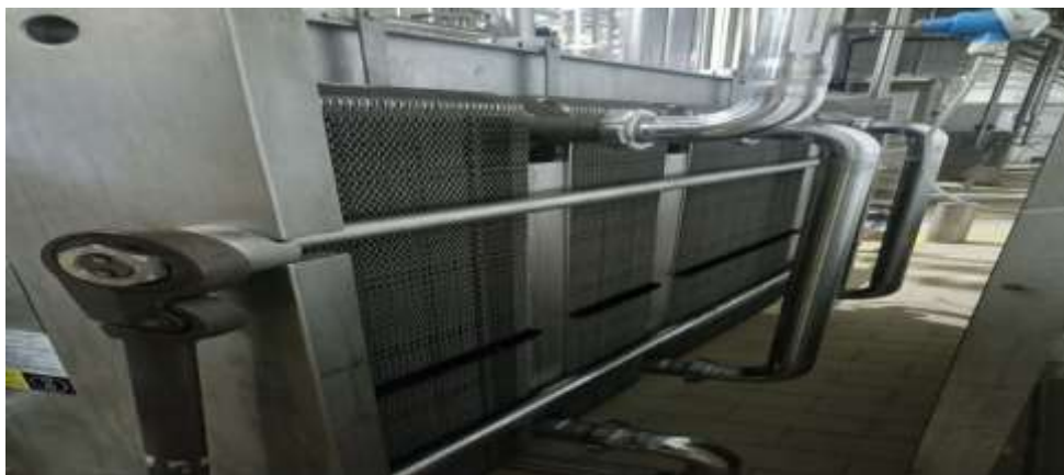
Figure II.4: Échangeur à plaques tubulaires CEVITAL
