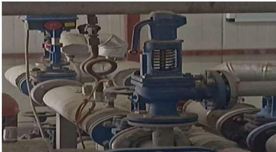
Figure II.7: Les soupapes de Sécurité CEVITAL
