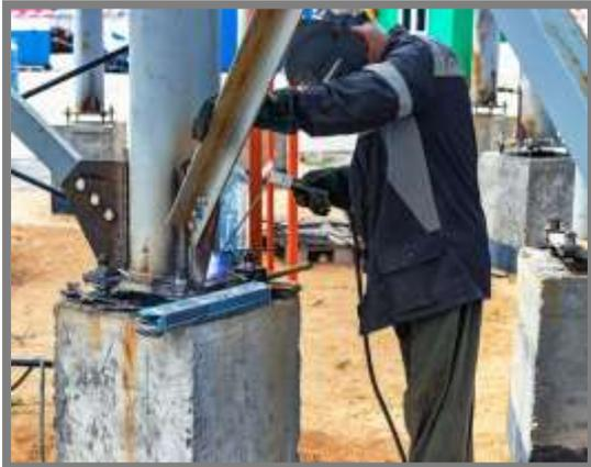
Figure I.2 – Procédés à l'arc électrique.
