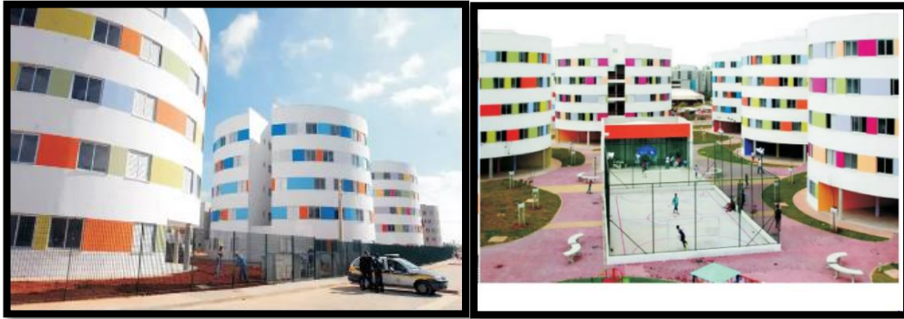
Figure 59 : Diversité des couleurs sur les façades des blocs d'habitations.(source:slideshare.net).
