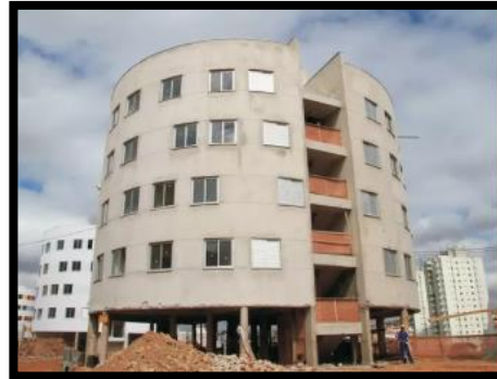
Figure 56: Bloc d'habitation lors des travaux de chantier, sans revêtement extérieur.(source:slideshare.net).
