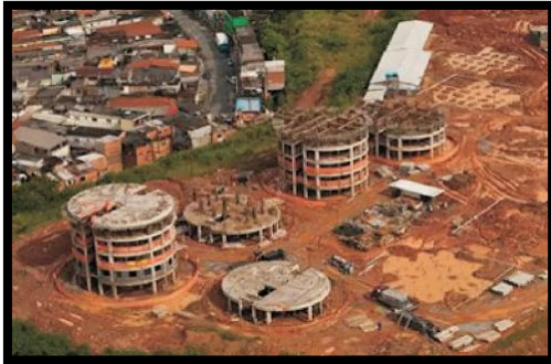
Figure 55: Le projet lors des travaux de construction.(source:slideshare.net).
