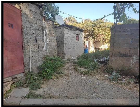
Figure 18: Construction en parpaing sans revêtement extérieur.(source:auteur,2024).
