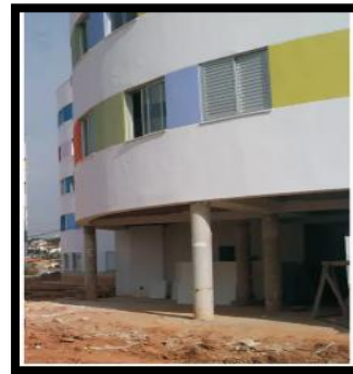
Figure 58: Bâtiment reposant solidement sur des pilotis(source:slideshare.net).
