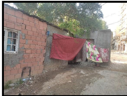
Figure 19:Construction en briques sans revêtement extérieur.(Source:auteur,2024).
