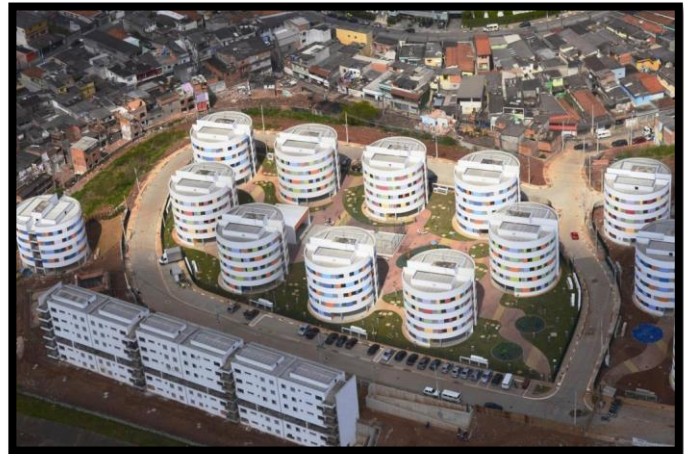
Figure 53: Vue aérienne du projet (source: archdaily.com).
