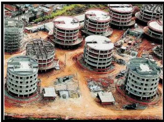
Figure 60: Mise en œuvre des boîtes d'eau sur les toitures.(source:slideshare.net).
