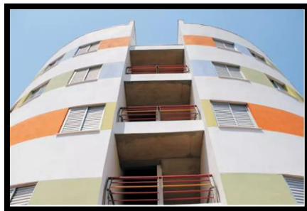
Figure 57: Peinture sur les façades extérieures des blocs d'habitations.(source:slideshare.net).
