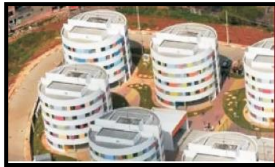
Figure 61: Toitures plates des blocs d'habitations.(source:slideshare.net).
