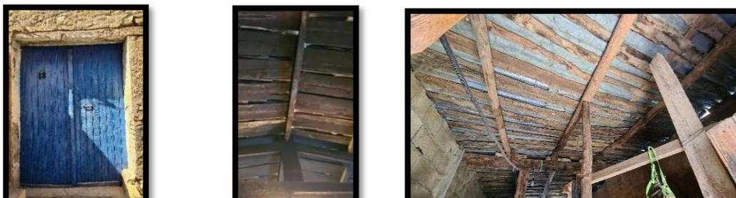
Figure67: : utilisation le bois pour la superstructure et les portes
