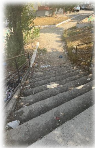
Figure 44 : des escaliers extérieurs à la cité frère boucherba (600 logs), source auteur, 2024
