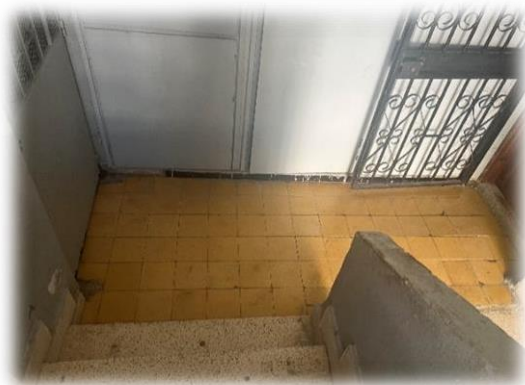
Figure 48 : un palier d'un bâtiment à la cité frère boucherba (600 logs), source auteur, 2024
