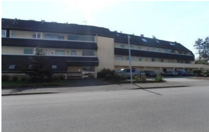
Figure 116: photo de projet de la bosse, Saint-Nazaire, source : presse Océan, ouest France, 2018
