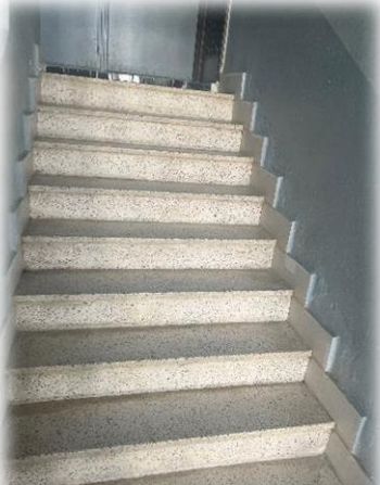
Figure 47 : cage d'escalier d'un bâtiment à la cité frère boucherba (600 logs), source auteur, 2024
