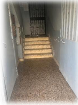
Figure 46 : Hall d'entrée d'un bâtiment à la cité frère boucherba (600 logs), source auteur, 2024
