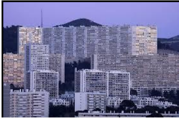
Figure 1 : Grand ensemble de La Rouvière à Marseille, France. (Source : https://www.lesechos.fr/2014/07/la-rouviere-residence-village-de-marseille-1103088 )
