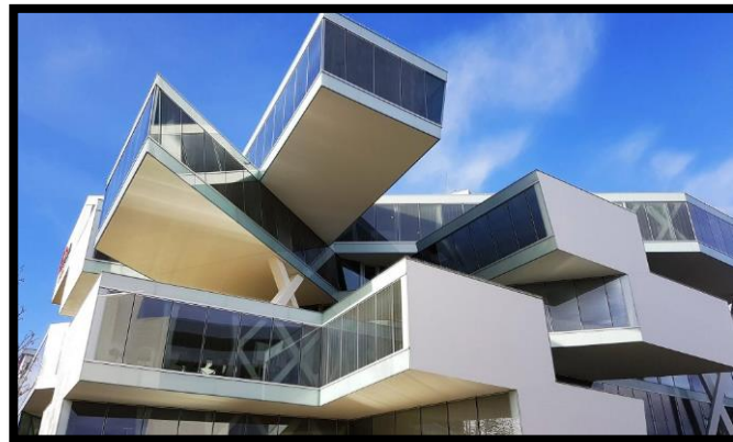
Figure 13: logement en bâtiments de fonction
