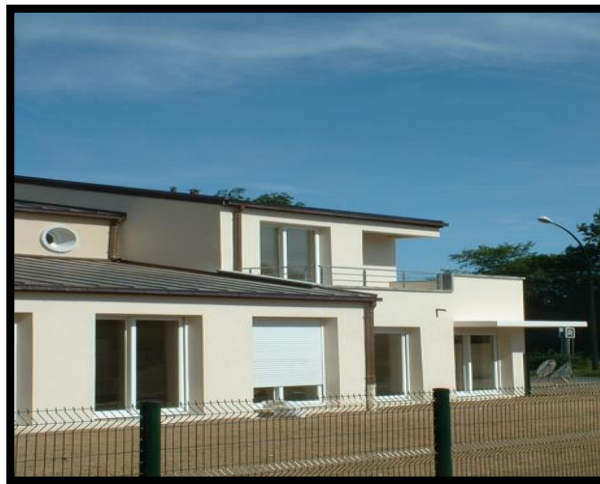
Figure 50 : Logements de fonction du SDIS 91 - Novak-Menier
