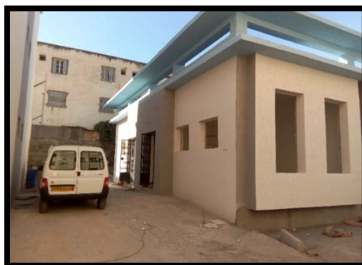
Figure 44 : logement de fonction de lycée type 1000 / 300 r sidi aich (source : auteur)
