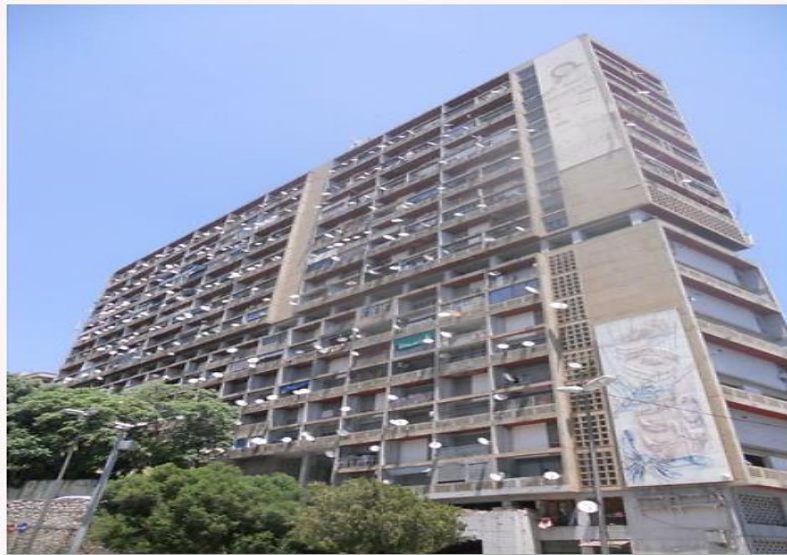
Figure 31: L'aéro-habitat Alger 1954. (Source : https://www.aurelia-myrrho.com , Consulté : 23-03-2024 A 20 H)
