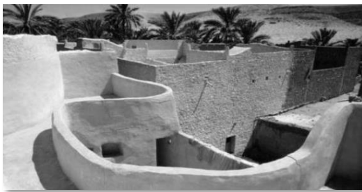
Figure 19 : Maison mozabite à l'extérieur. (Source : RAVEREAU. A, 1981).
