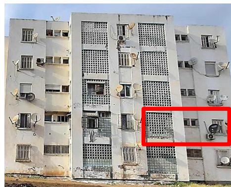
Figure 56: Façade Nord-ouest de logement. (Source: Auteur, 2023)
