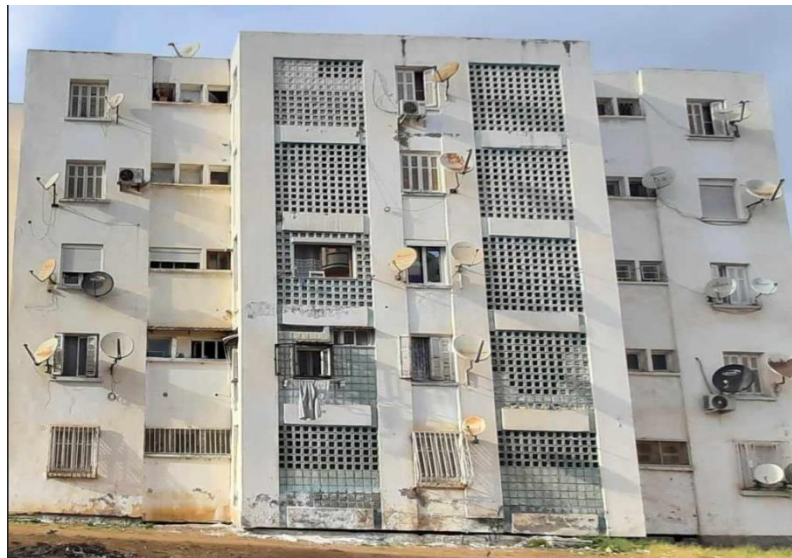
Figure 32: Bloc d'habitat collectif de la zone d'habitat urbain nouvelle, Iheddaden 1000 logements, Bejaïa. (Source : Auteur, 2023)
