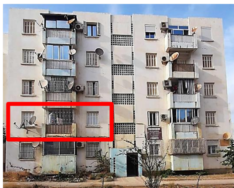
Figure 57 : Façade sud-est de logement. (Source : Auteur, 2023)
