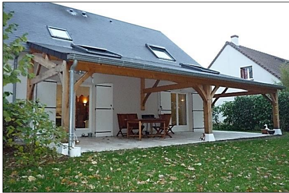
Figure 25 : protection solaire horizontale type auvent (source : https://www.fermeture-online.com,2024 )
