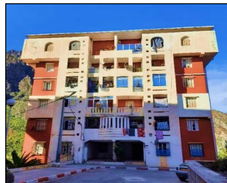
Figure 69 : photo de projet 90 logements RHP à kherrata (source : auteur, 2024)
