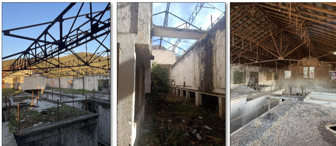
FIGURE 41: PHOTOS DE L'INTERIEUR DU BATIMENT VITICOLE
