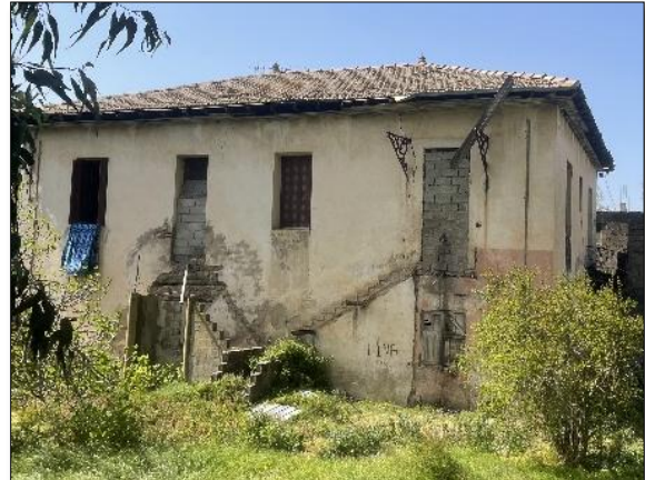
façade arrière actuelle
