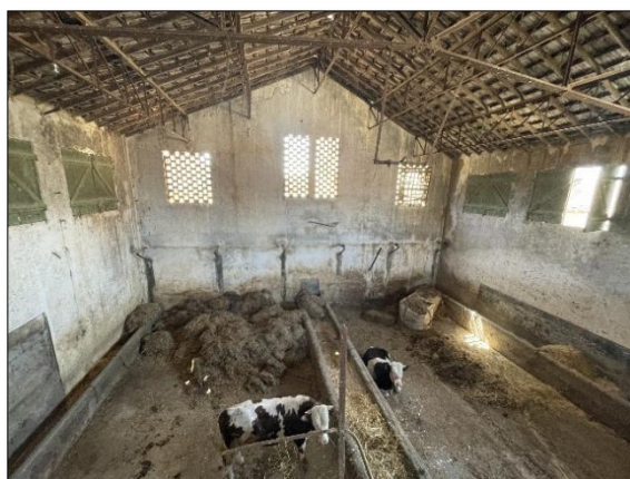
FIGURE 42: L'ANCIEN USINE DE VIN TRANSFORMER EN ETABLE
