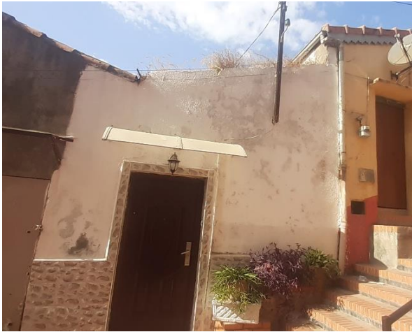
Figure 61: Entrée principale de la maison (sud-est) Source : Auteur, 2023
