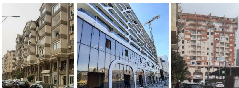
Figure 91: Façades contemporaines des bâtiments résidentiels environnants Source : auteur
