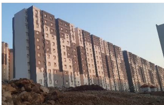
Figure 4 : Logement social de forme de barre (habitat collectif) à Ighzer Ouzarif Source : auteur, 2021
