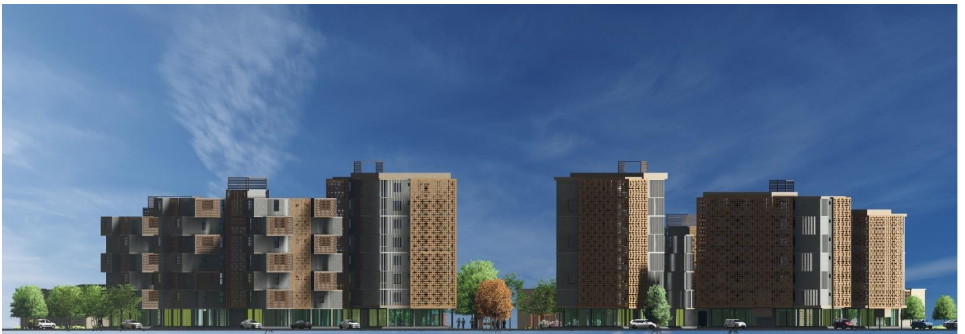
Vue de profil de l'habitat collectif
