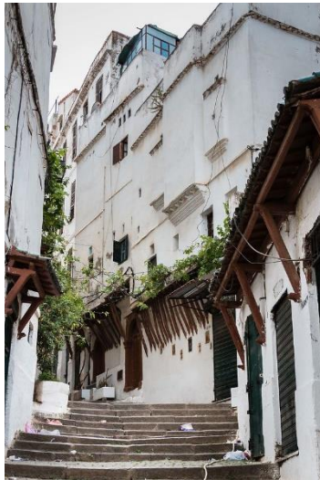
Figure 32: Façades extérieures monochromes et minimaliste d'une maison de la casbah Source : Sonia Fatima Chaoui, 2017
