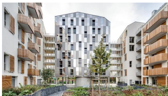
Figure 5 : Habitat collectif en France avec jardin central commun Source : A. Ramirez, 2023
