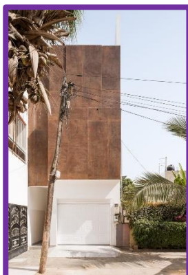
Figure 110 : Garage et entrée principale Source : A. Ciriani, 2020
