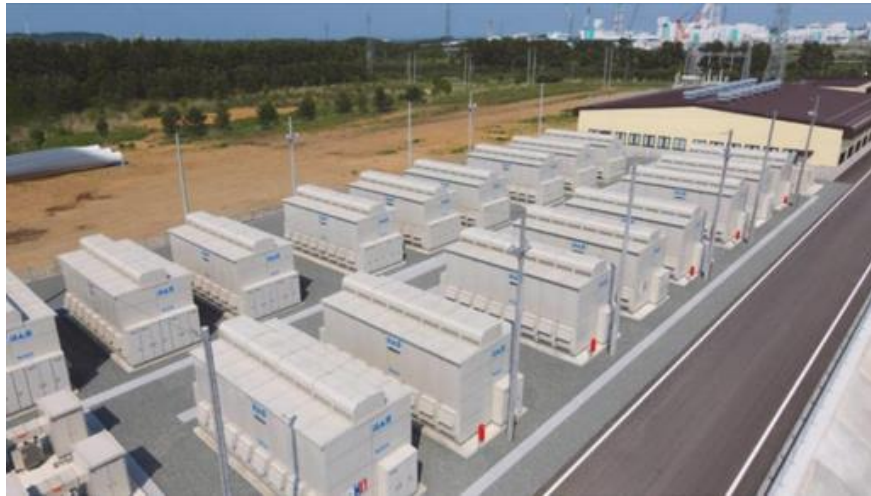
Figure II.12 : 17 ensembles de 2 MW de batteries NaS au Japon [16].
