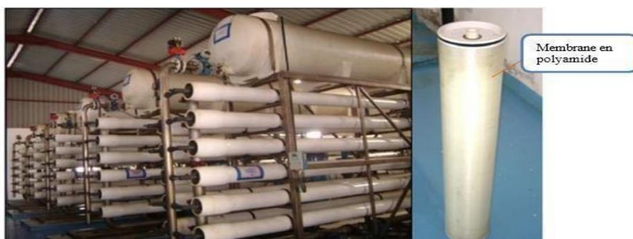
*Figure I.4 : Système de membranes d'osmose inverse*
