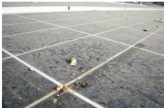
Figure II\_04: Ejections sur les panneaux photovoltaïques
