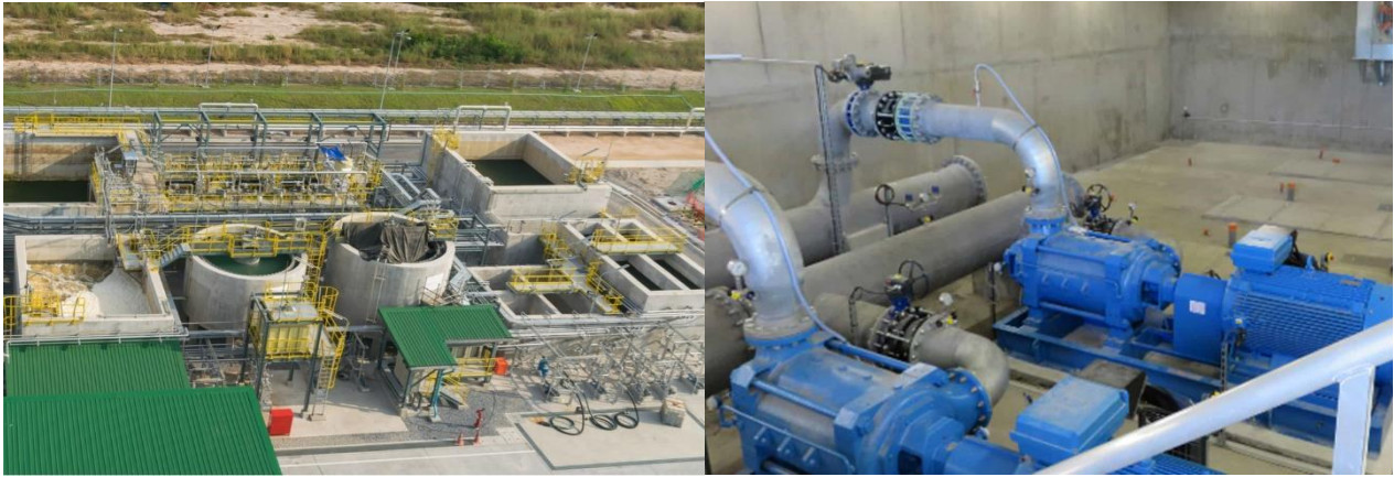
Figure I.5 : Projet de construction de stations de pompage marines [18]
