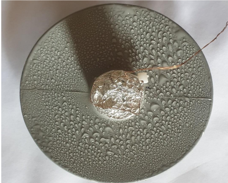
Figure.III.20: Répartition de la pollution sur la surface de l'isolateur silicone obtenue par pulvérisation.
