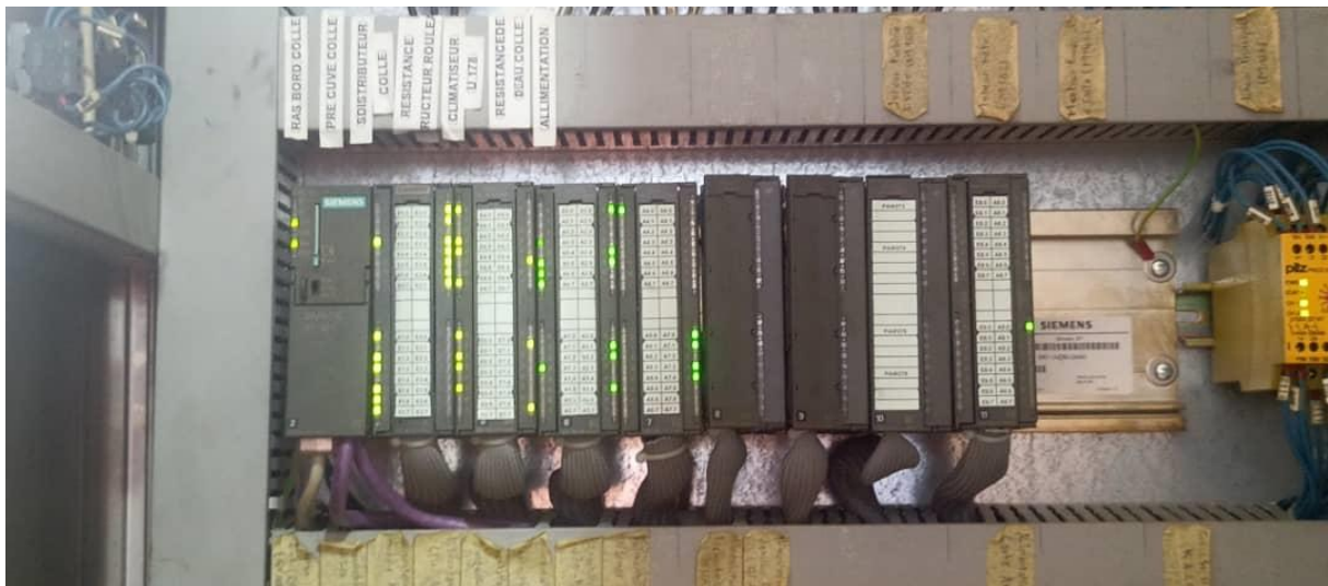
Figure II-4 : Automate modulaire
