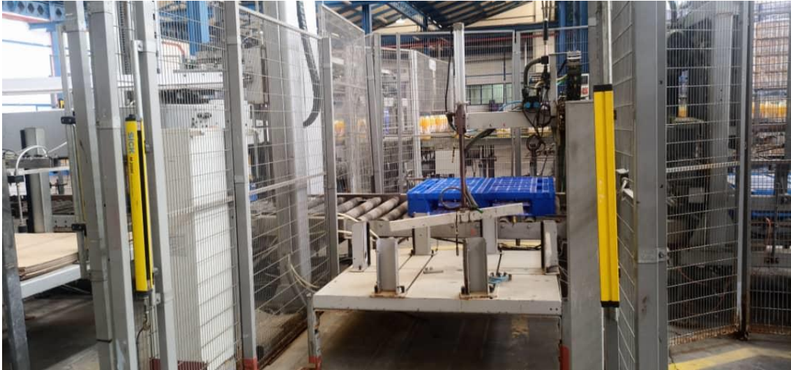
Figure I-13 : Barrière de sécurité
