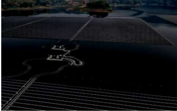
Figure (I-31) : Plus grand parc solaire flottant de l'Asie du Sud-est, Jakarta [51].
