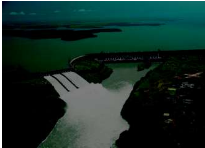
Figure (I-36) : Barrage d'Itaipu, Brésil [54].
