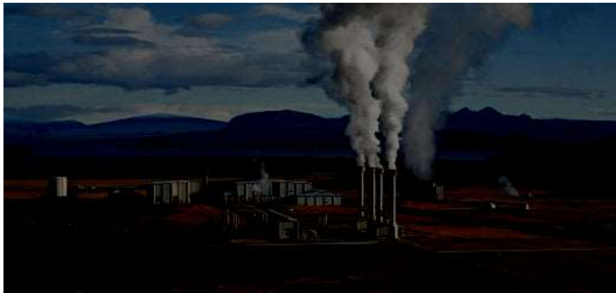
Figure(I-15) : La centrale géothermique de Hellisheiði à Hengill , Islande [27].
