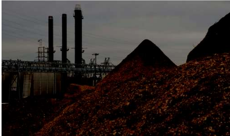
Figure (I-33) : Centrale de biomasse, états unis [52].
