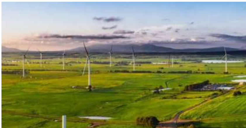
Figure (I-40) : Parc éolienne Stockyard Hill victoria, Australie [57].
