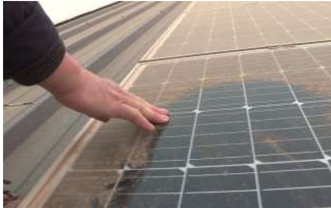
Figure (III-14) : poussière du dessert sur des panneau PV.
