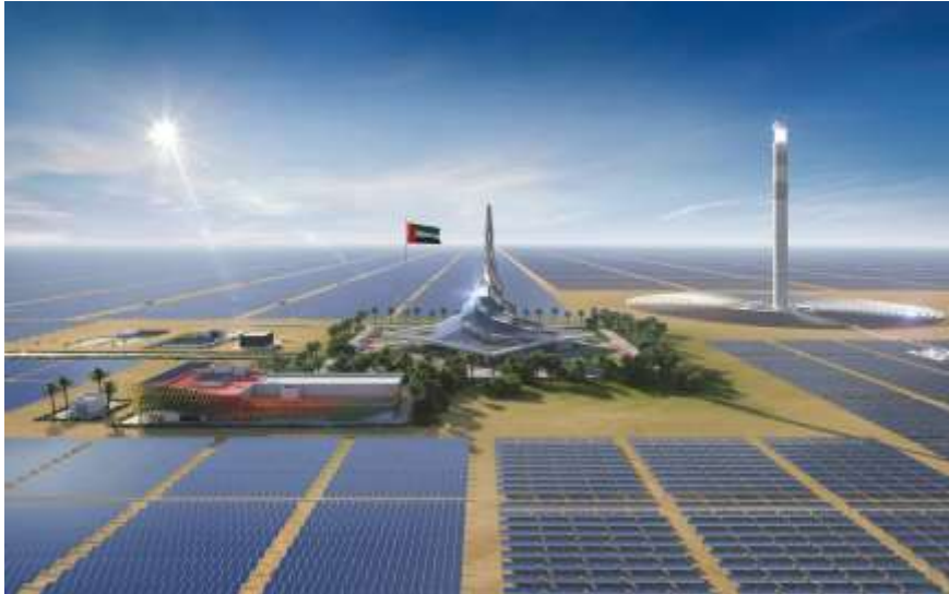
Figure (I-1) : Le parc solaire Mohammed ben Rashid al-Maktoum à dubai,émiirates arab unis [2].
