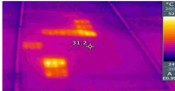
Figure (III-11) : Caméra thermique spécialisée, qui met en évidence les disparités de température entre les différentes cellules.
