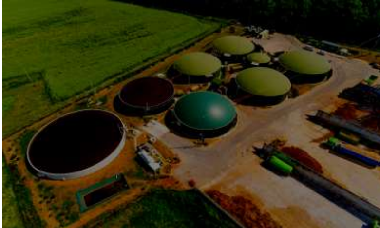
Figure (I-28) : Usine et ferme de biogaz dans la république tchèque Europe [46].
