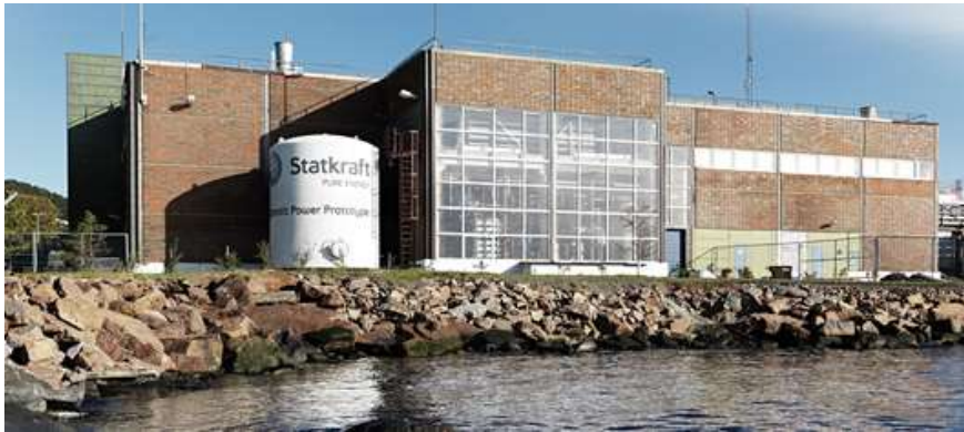
Figure(I-26) : centrale osmotique en Norvège [43].
