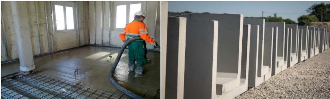
*Figure I. 2 : Application du BAP dans les planchers et dans la préfabrication.[5]*
