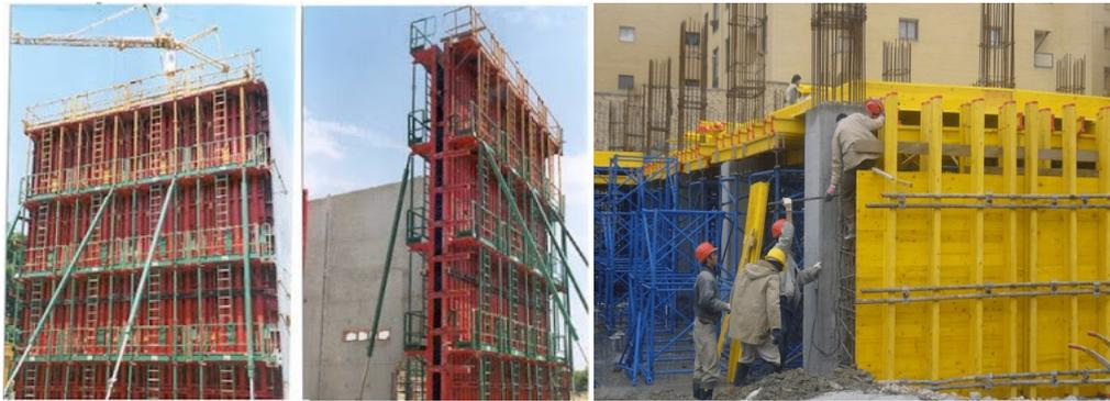
*Figure I. 15 : coffrage utiliser pour les BAP.[26]*
