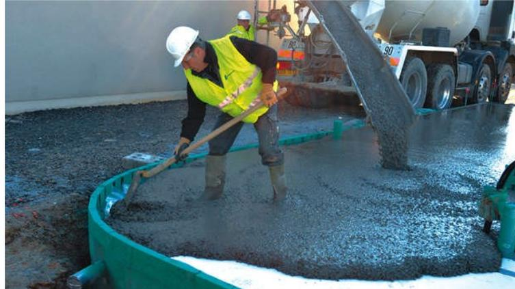
*Figure I. 16 : Mise en place du BAP par un ouvrier [27].*
