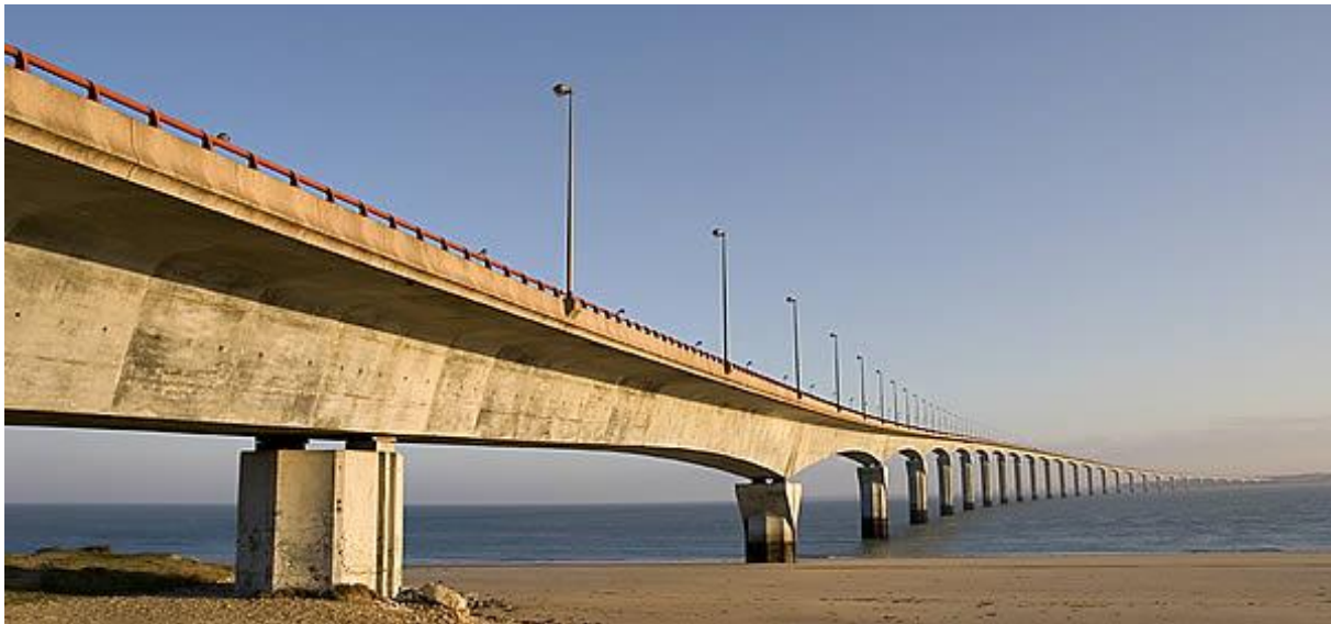
Figure I.2 exemple pont a poutre [1]
