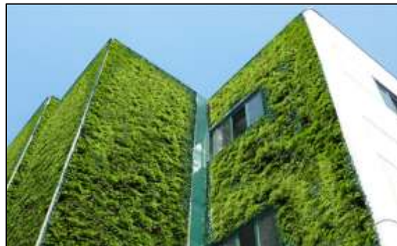
Figure I.18. Mur végétal extérieur [44]
