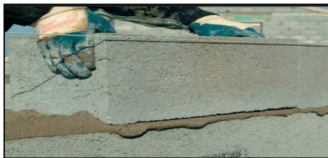
Figure I.5 Pose de mortier de hourdage
