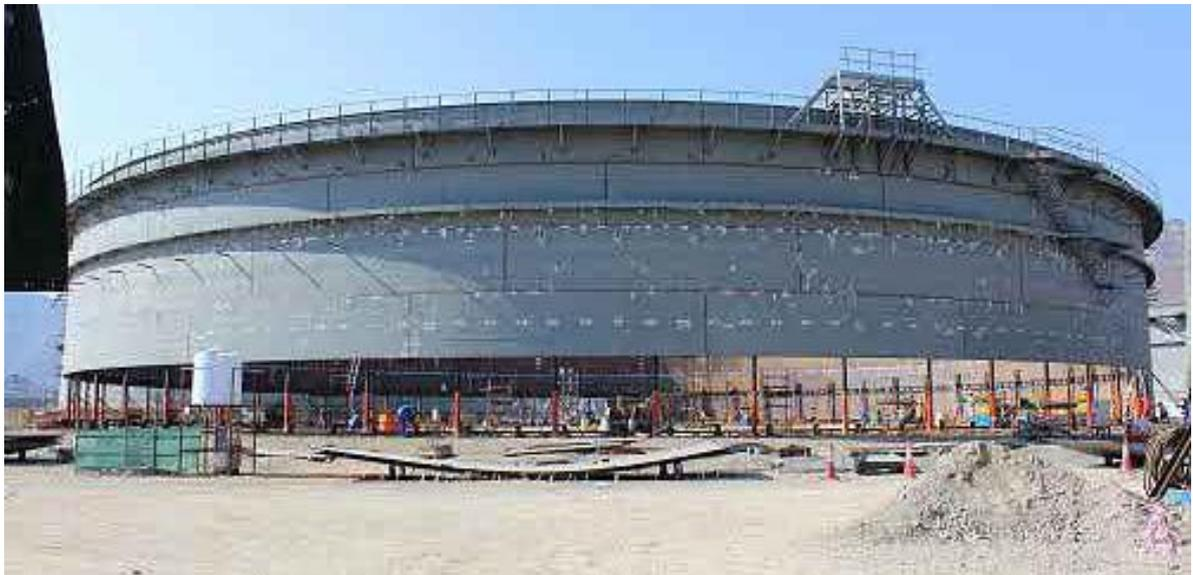
Figure (I.13) : méthode de levage [13].
