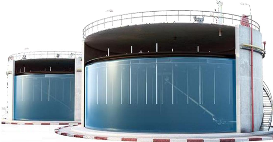
Figure (I.04) : réservoir à toit flottant interne [8].
