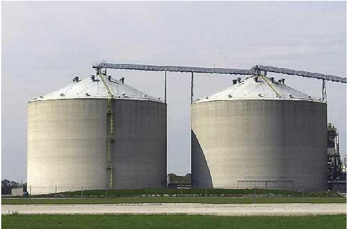
Figure (I.02) : réservoir à toit fixe [7].
