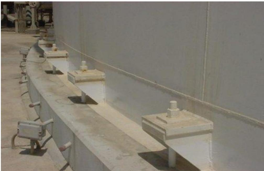
Figure (VI.01): Ancrage du réservoir [15].
