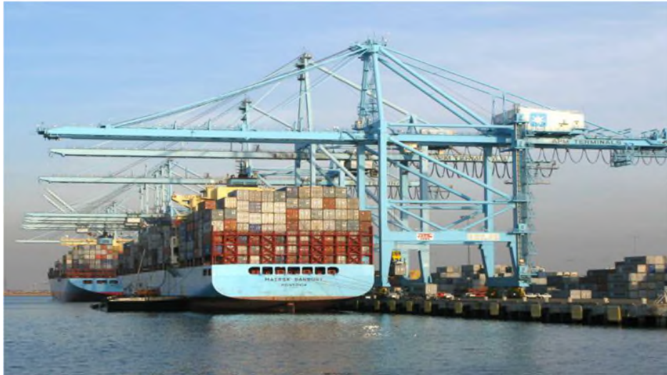
FigureN°03 : grue de quai
