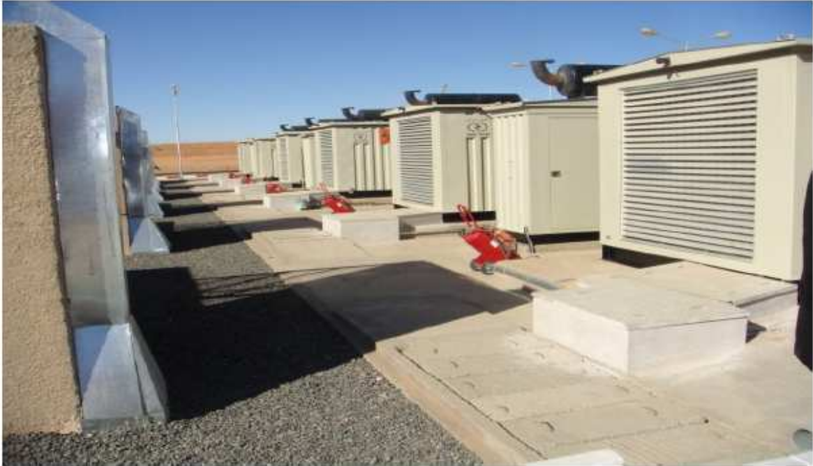
Génie Civil de la centrale électrique de Bordj El Haouas
