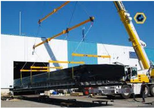
*Figure 38 : Palonnier de levage*
