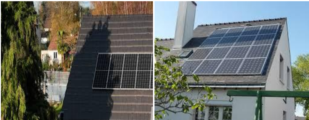
Figure II.11 : Ombrage partiel sur les panneaux photovoltaïques
