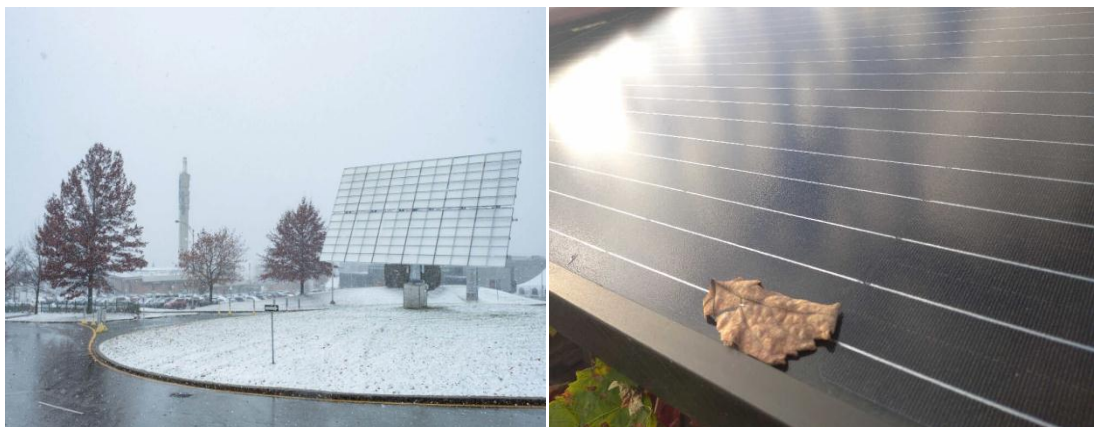
Figure II.12 : Ombrage total sur les panneaux photovoltaïques
