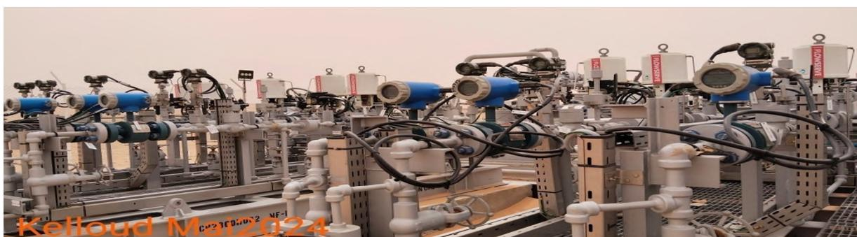
**Figure I.13 :** Pompes et débitmètre de la station haute pression
