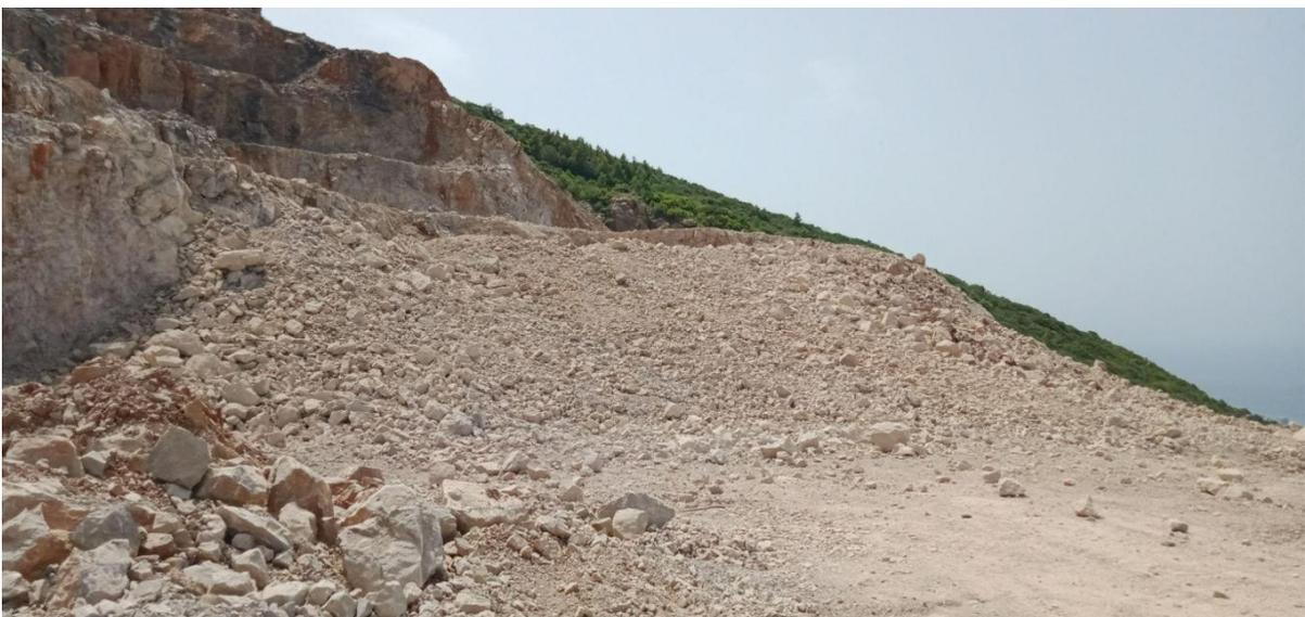
**Figure III.2** : Image du gradin prise après le tir.
