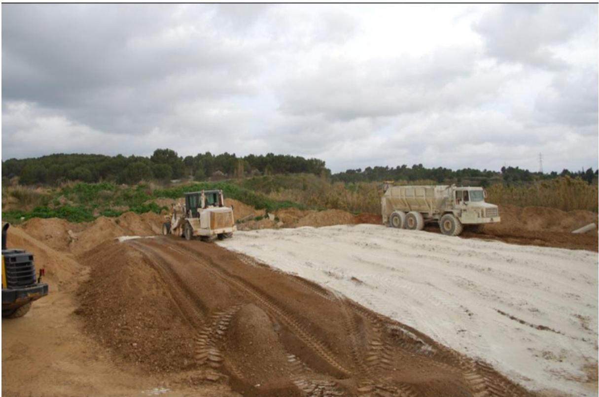
*Figure II.7 : Traitement du sol à la chaux [9]*
