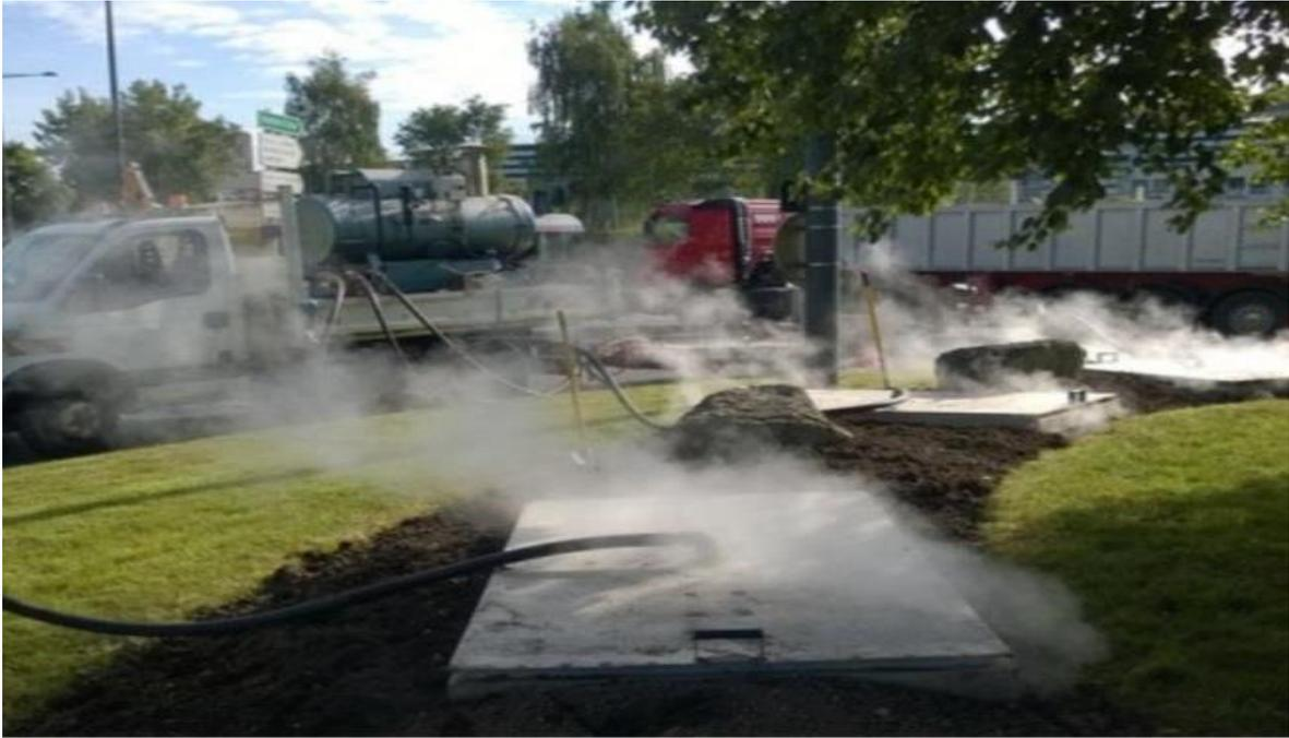
*Figure II.6 : Traitement thermique par chauffage par vapeur [8]*
