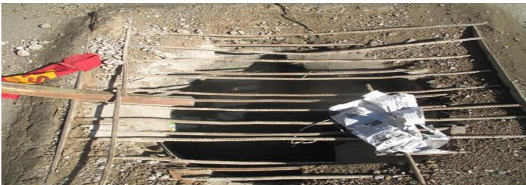
**Figure III.8 :** regard avec tampon endommagé. [3]
