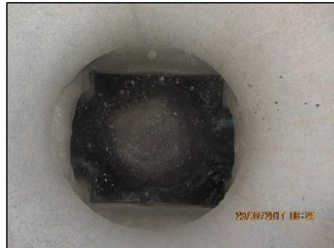
**Figure III.9 :** Regard avec partie circulaire et partie rectangulaire. [3]
